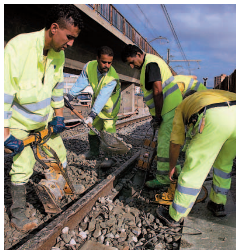
Los operarios ultiman el arreglo de la vía tras tapar el doble cráter
