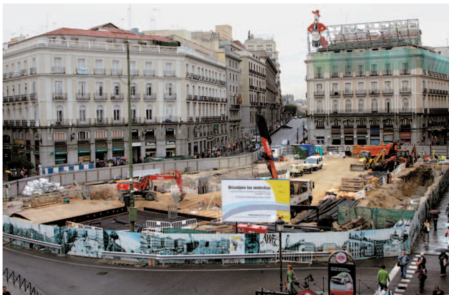
Puerta del Sol. Las obras de la estación, construida a 40 m de profundidad, ocupan la parte oriental desde hace un año
